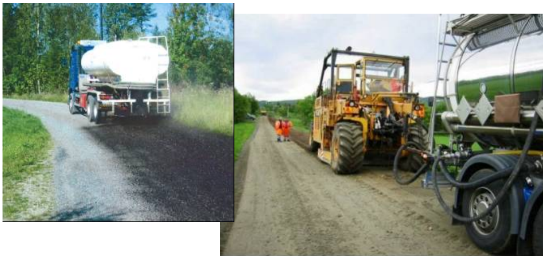
Figur: Støvbinding og dypstabilisering med Dustex
